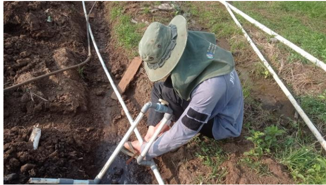
Gambar 4. 7 Perawatan Jaringan Irigasi
