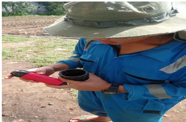
Gambar 4. 6 Pembersihan Disc filter
