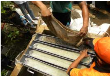
Campuran zeolit kecil dan kompos digunakan sebagai lapisan atas
