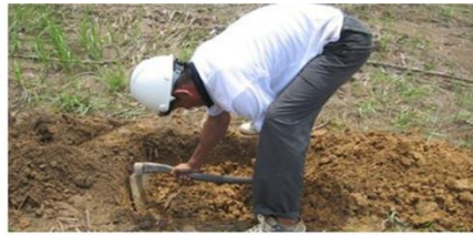
2) Digali memisahkan Top Soil – Sub Soil
