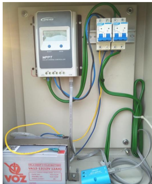
Gambar 3. 8. Rangkaian jalur kelistrikan dalam Box Panel
