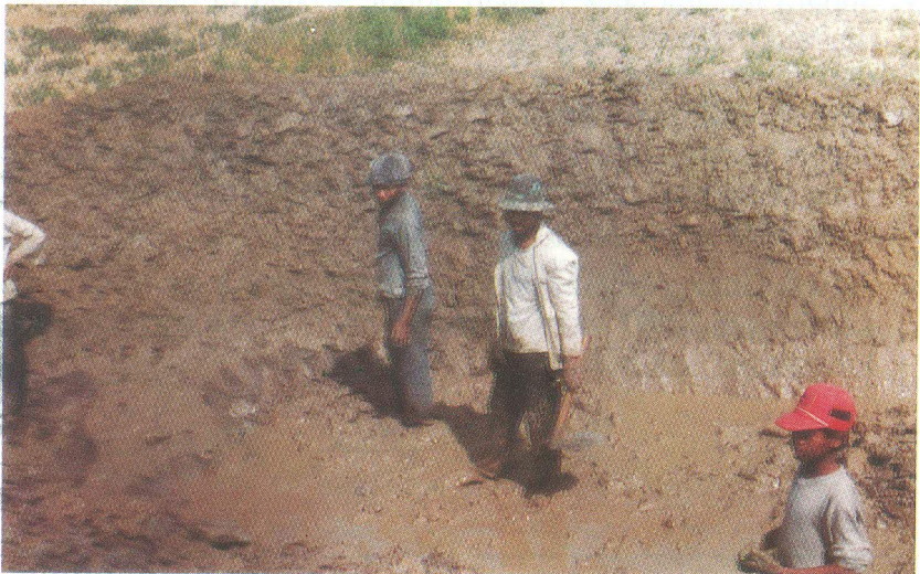
Dinding embung dilapis dengan tanah liat
