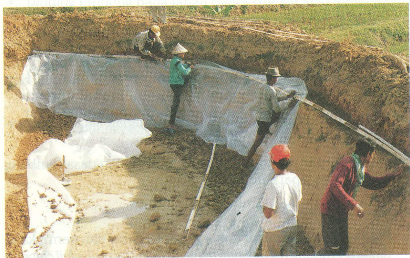
Dinding embung dilapis dengan plastik.
