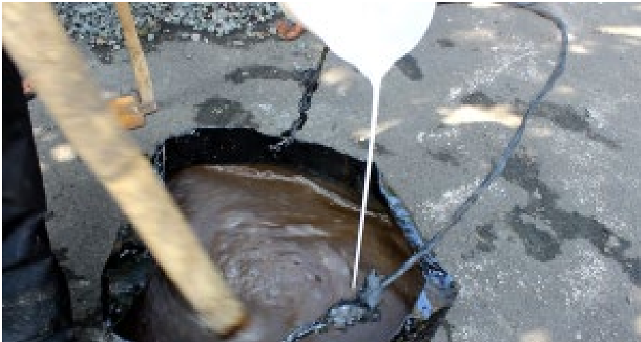
Gambar 21. Pencampuran lateks K-Pravul dengan aspal Sumber : Puslit Karet (2016)
