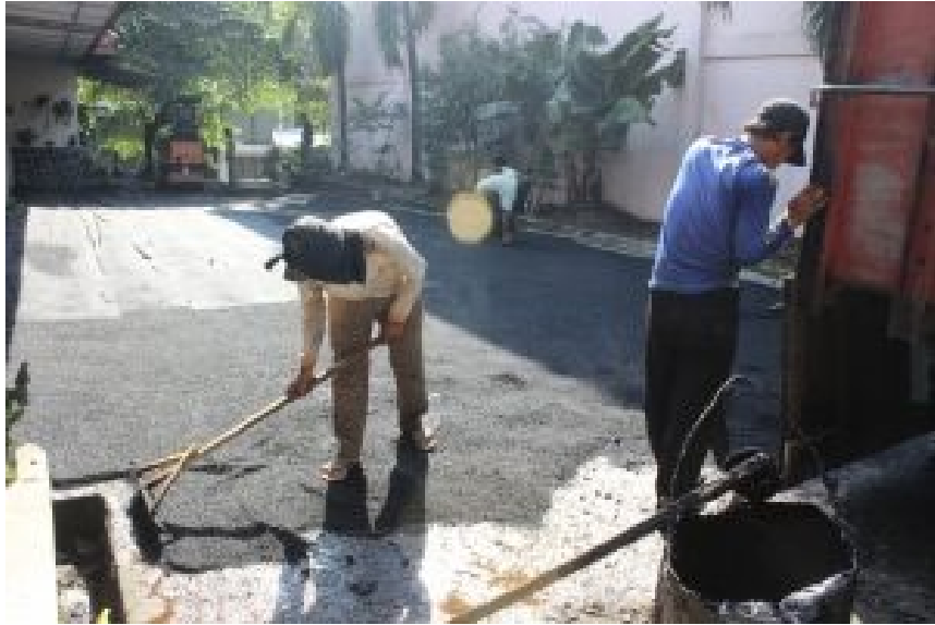
Gambar 22. Percobaan penghamparan aspal dengan aditif lateks K-Pravul Sumber : Puslit Karet (2016)
