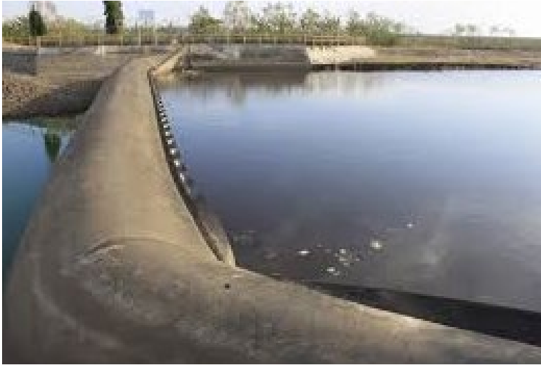
Gambar 29. Bendungan karet Sumber : Balitbang PU (2004)
