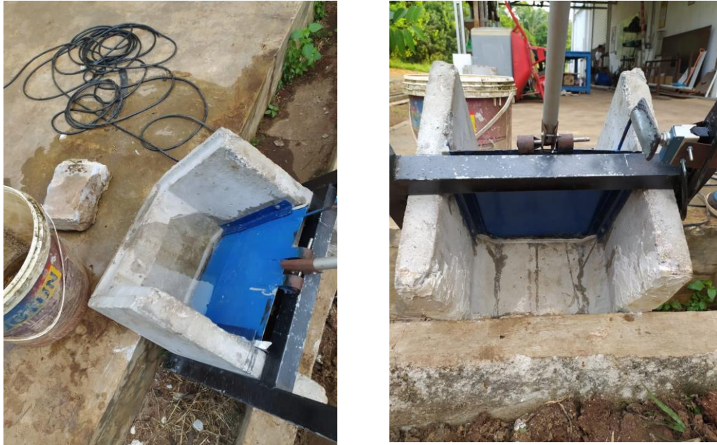
Gambar 4.9 Pengujian Ketahanan Pintu Air
