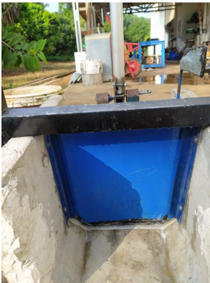
Gambar 4.3 Desain Plat pintu air
