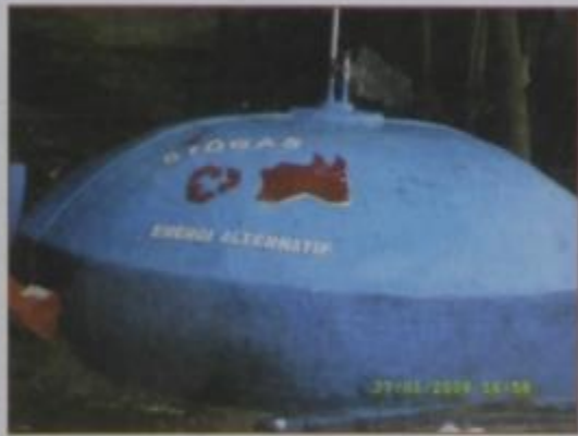
Gambar 11. Kubah Pada Fixed Dome Digester
