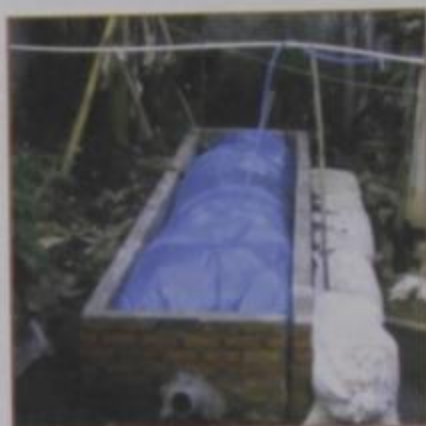
Gambar 13. Penampung Gas Pada Floating Digester
