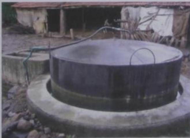
Gambar 16. Konstruksi Floating Digester
