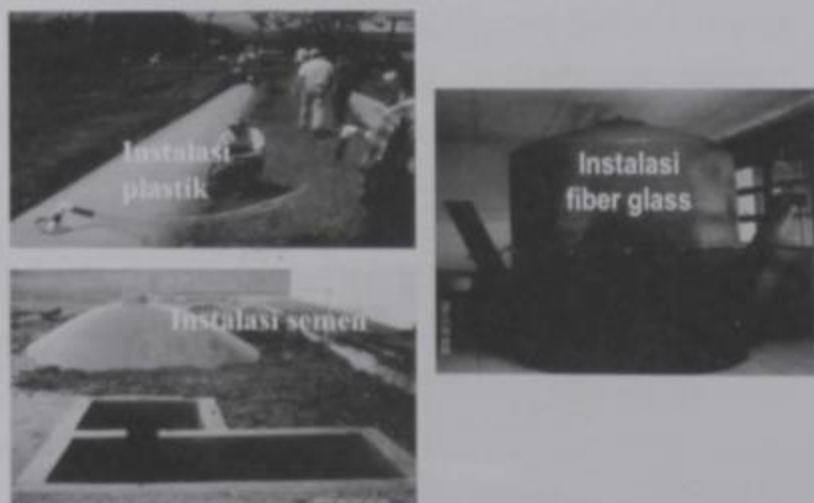
Gambar 5. Instalasi Biogas dari Bahan Plastik, Fiber Glass dan Semen Beton
