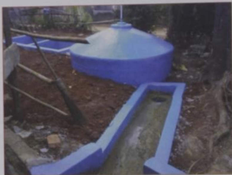
Gambar 9. Konstruksi Fixed Dome Digester
