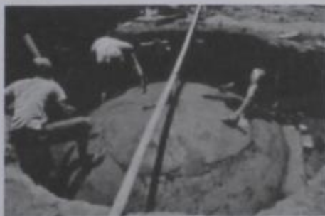
Gambar 18. Pembuatan Kubah Digester
