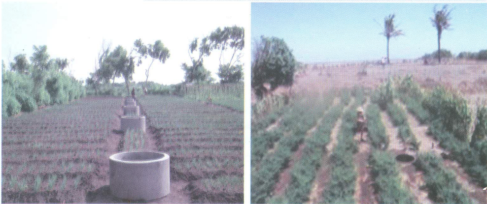
Gambar 3. Sumur Renteng di Kabupaten Bantul dan di Kulon Progo
