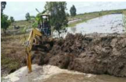
Gambar 6. Pemeliharaan surjan dengan menambahkan tanah dari tabukan menggunakan excavator
