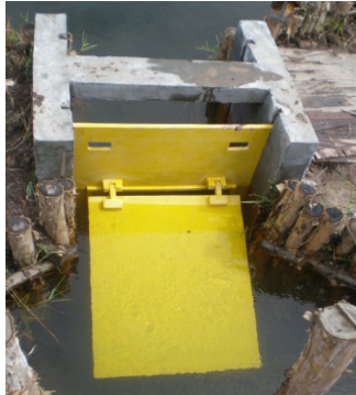
Gambar 1. a. Sistem tata air satu arah dan model pintu air ( flapgate ); b. Model tabat untuk mempertahankan muka air tanah, terbuat dari beton; c. Pintu air pada system tata air satu arah dan tabat konservasi (SISTAK) (Sumber : Dok. Balittra)
