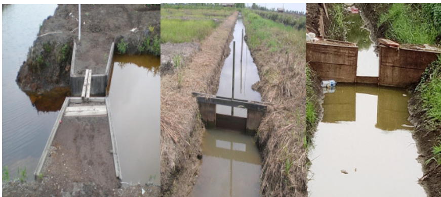
Gambar 4. Model tabat limpas dari bahan kayu di lahan rawa tipe luapan C. Dokumen: Anwar (2008, 2017) dan M. Noor (1996)
