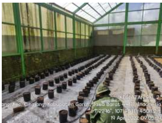
Gambar 19. Pemasangan pipa HDPE dan media tanam (Dokumen Pribadi)
