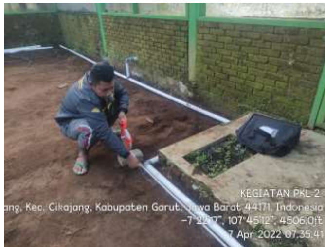
Gambar 17. pengukuran pipa pvc (Dokumen Pribadi)
