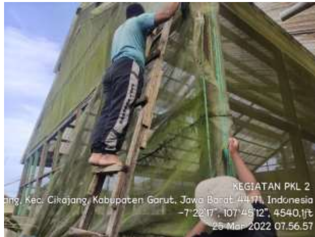
Gambar 13. Pemasangan Insectnet (Dokumen Pribadi)
