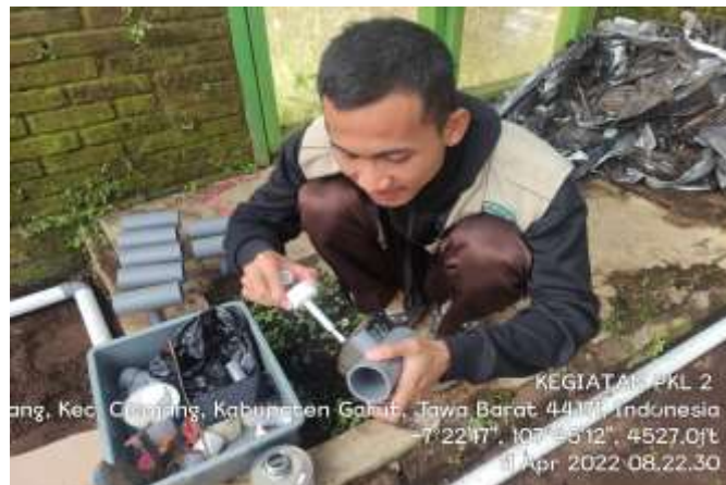
Gambar 18. Pengeleman pipa pvc (Dokumen Pribadi)
