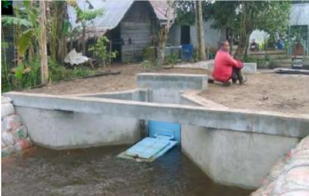
Gambar 7. Sistem pintu air makro di saluran primer yang masuk menuju saluran sekunder area lahan budidaya
