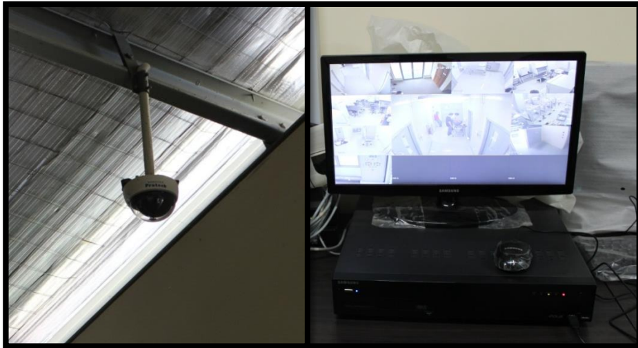
Gambar 8. Alat CCTV dan monitor untuk memantau akses masuk dan keluar Personil
