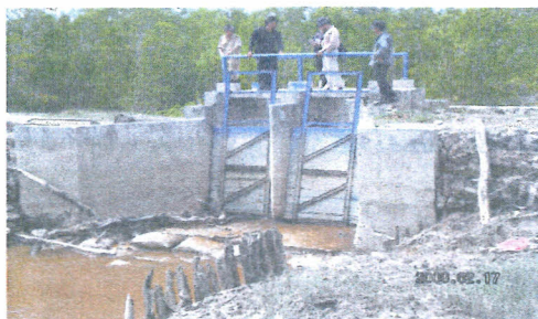
Gambar 10. Pintu air model flapgate di Sungai Mud yang baru dibangun
