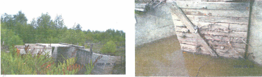
Gambar 8. Model pintu air dan daun pintu hasil modifikasi petani.
