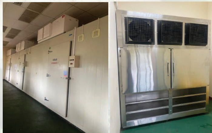
Bagian luar cold storage (Sumber: Dewi, 2022)
