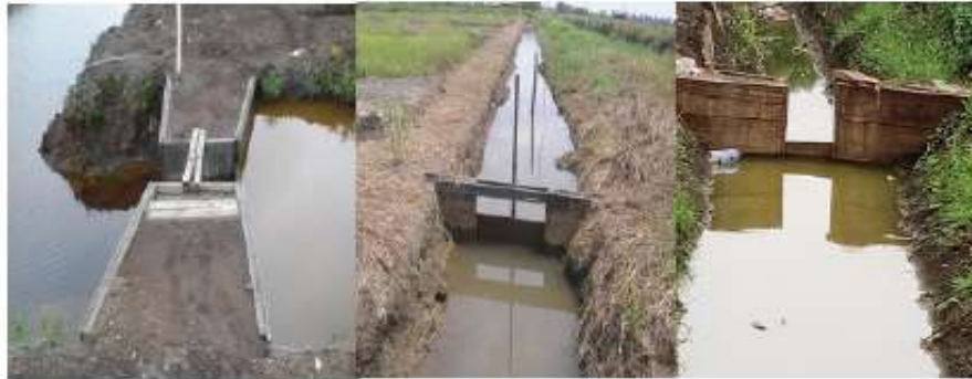
Gambar 4. Model tabat limpas dari bahan kayu di lahan rawa tipe luapan C. Dokumen: Anwar (2008, 2017) dan M. Noor (1996)
