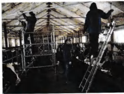
Tinggi kandang dari tanah
