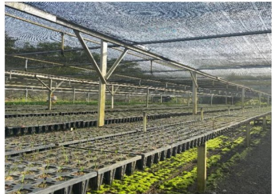
Lampiran 4 Instalasi bibitan
