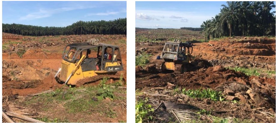
Gambar 3. 15 Pembuatan terasan
