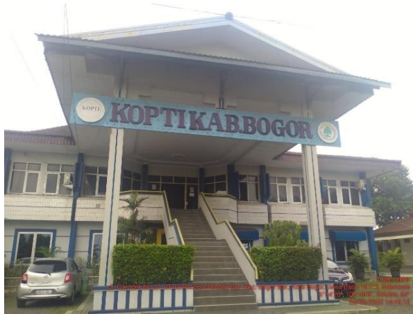
Gambar 4. 1 Bangunan RTI (Sumber: Dokumentasi pribadi, 2022)
