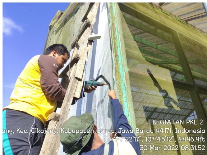
*Gambar 9. Pemasangan Insecnet*
