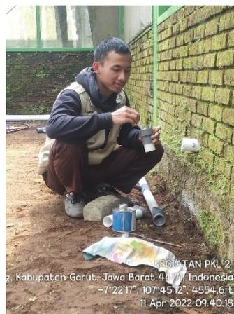
*Gambar 12. Pemasangan Pipa distribusi*
