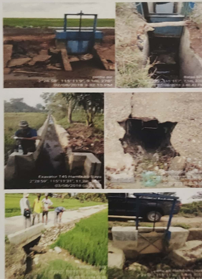
Gambar 10. Keragaan infrastruktur Mini-polder Hambuku 2018. (1) Dan (2) pintu penghubung saluran irigasi polder dengan Mini-polder; (3) Saluran irigasi Sungai Nagara ke area mini-polder; (4) Jalan inspeksi irigasi yang berfungsi sebagai tanggul penahan air saluran irigasi polder dengan area mini-polder, dibobol petani; (5) Jembatan penghubung yang belum memiliki pintu pengendali air; dan (6) Pintu penahan luapan Sungai Nagara.
