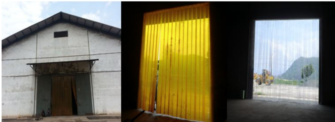
Gambar 4 Pintu gudang yang dilapisi tirai plastik ( plastic curtain )
