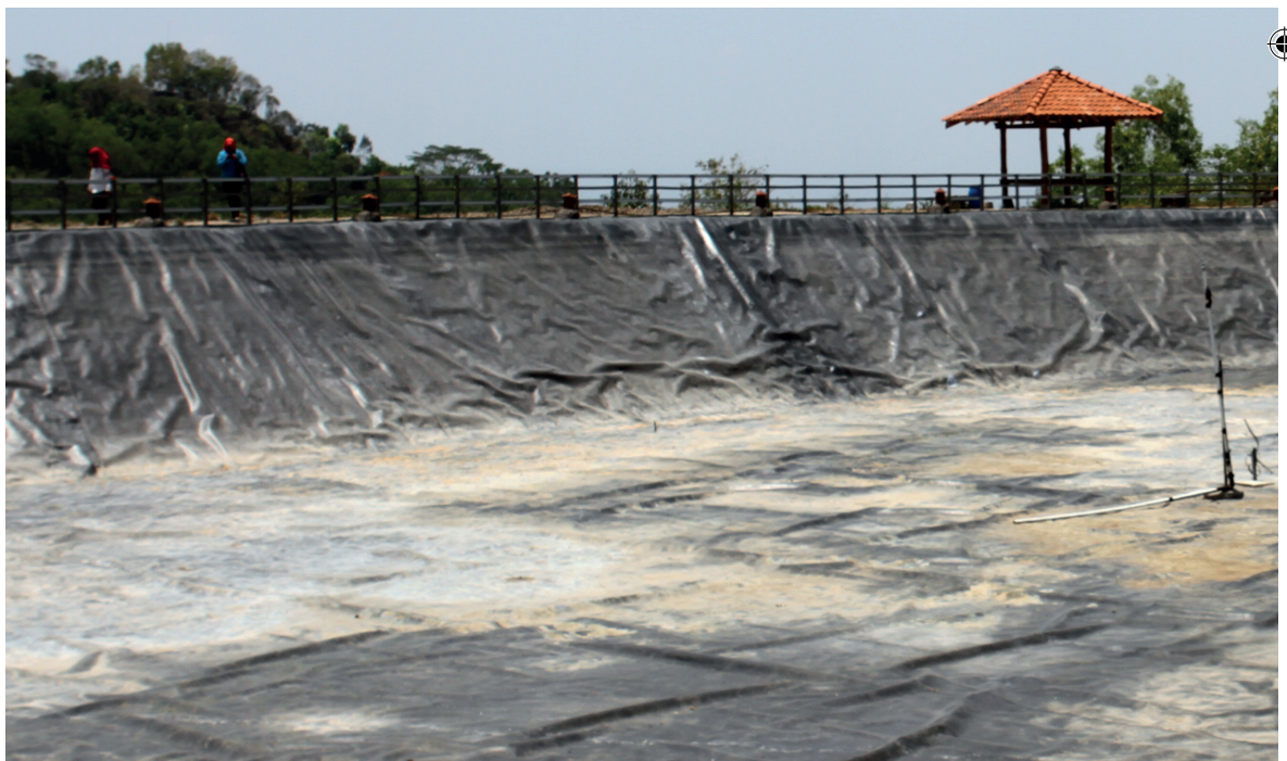
Geomembran dipakai sebagai alas di embung Nglanggeran
