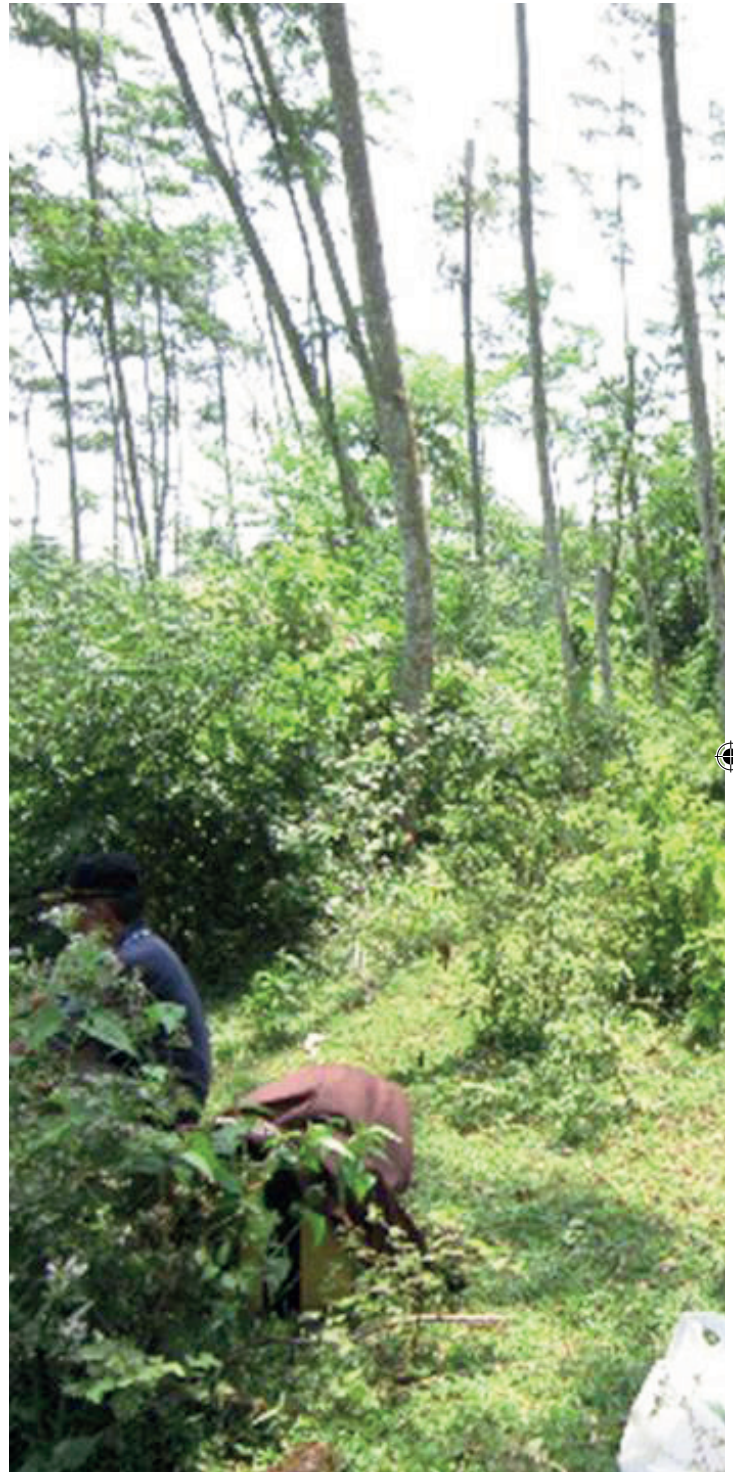
Penetapan titik patokan pengukuran ( benchmark )
