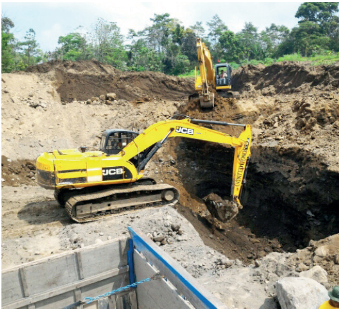
Penggalian tanah untuk pembangunan embung
