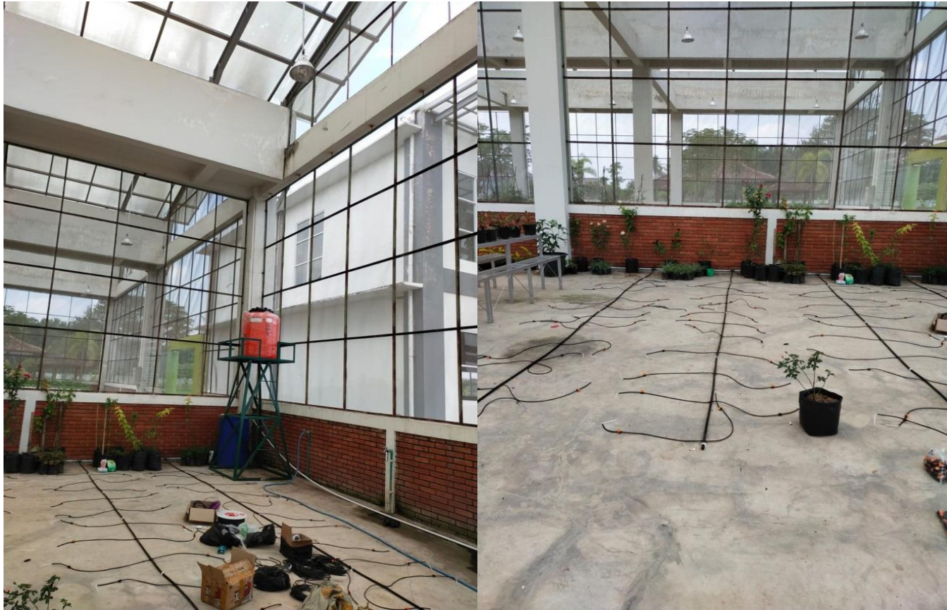
Pemasangan Instalasi Perpipaan Smartfarming
