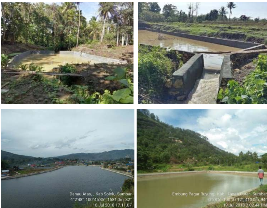
Gambar 1. Embung yang dibangun di Toli-toli, Sulawesi Selatan dan di Solok, Sumatera Barat
