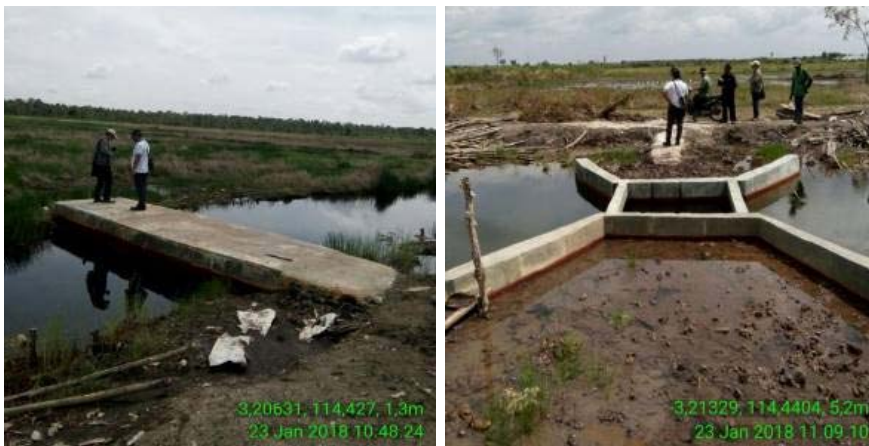
Gambar 2. Dam Parit di lahan rawa pasang surut
