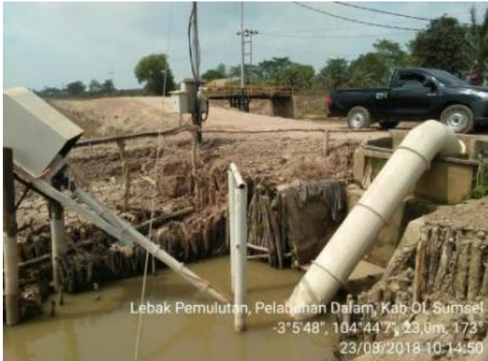
Gambar 50. Tanggul dan Pintu Air pada Polder di Rawa Lebak
