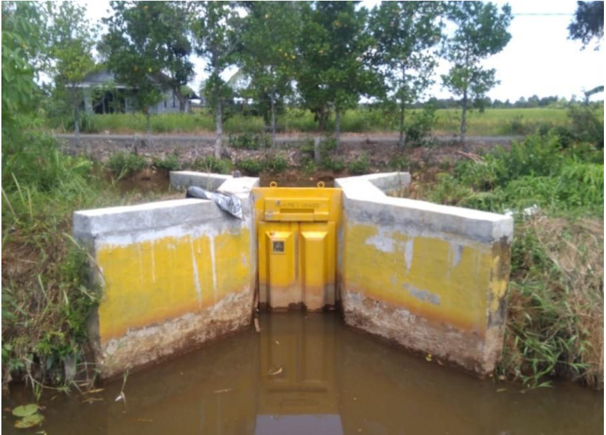
Gambar 52. Pintu Air Model Ayun pada Kebun Percobaan Belandean
