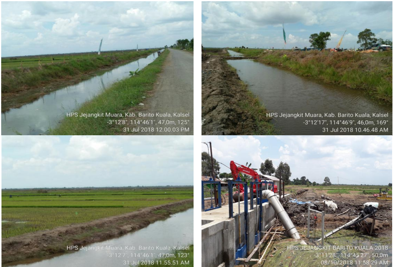
Gambar 2. Penataan saluran dan pompa axial (kanan bawah) pada muara saluran sekunder lahan rawa pasang surut Desa Jejangkit Muara, Kabupaten Barito Kuala, Kalimantan Selatan
