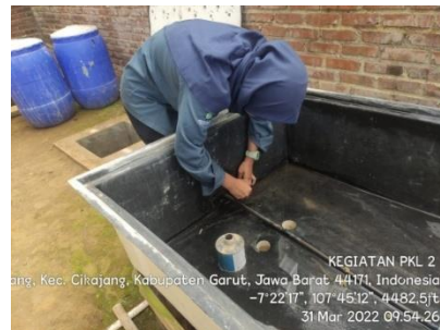
Perbaikan instalasi Aeroponik
