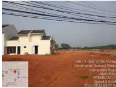
Gambar 4.9. Proyek pembangunan perumahan
