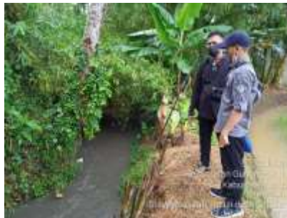
Gambar 4.10. Kondisi saluran irigasi Desa Cidokom
