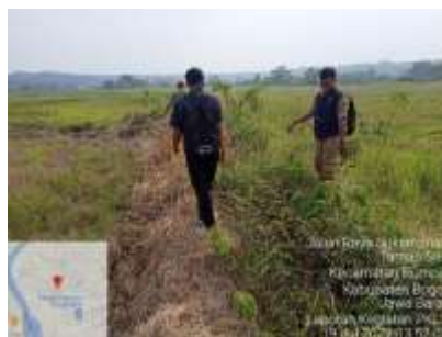
Gambar 4.6. Kondisi saluran irigasi Desa Jampang
