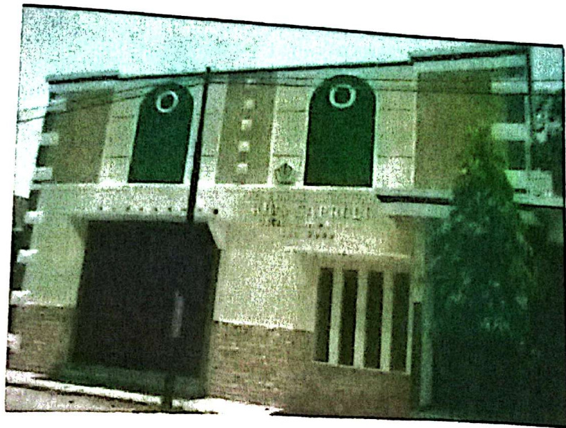
Bangunan Kios Saprodi
