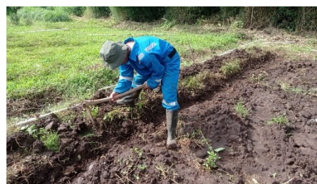
Gambar 8. Pembuatan Saluran Drainase (sumber : dokumentasi pribadi )
