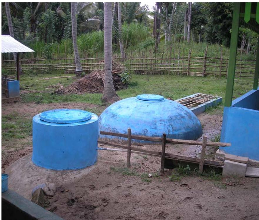
**Gambar 2.** Biodigester konstruksi beton
