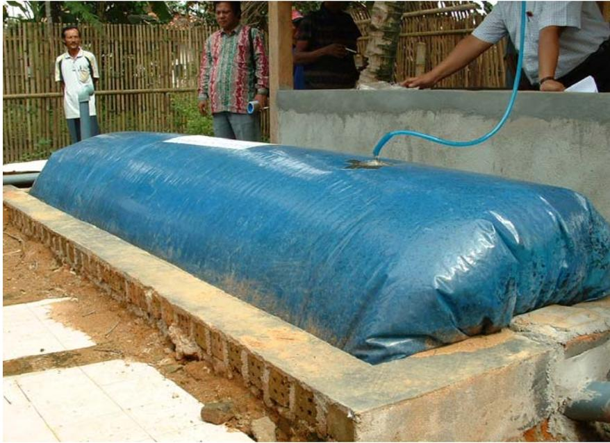
**Gambar 3.** Biodigester konstruksi plastik
