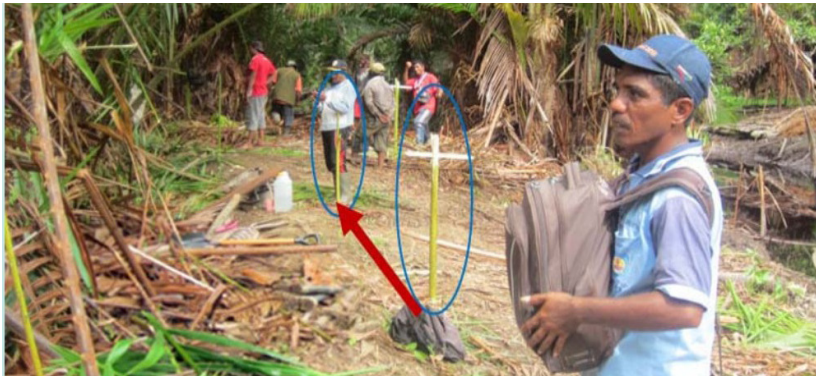
Pembuatan jalan blok
