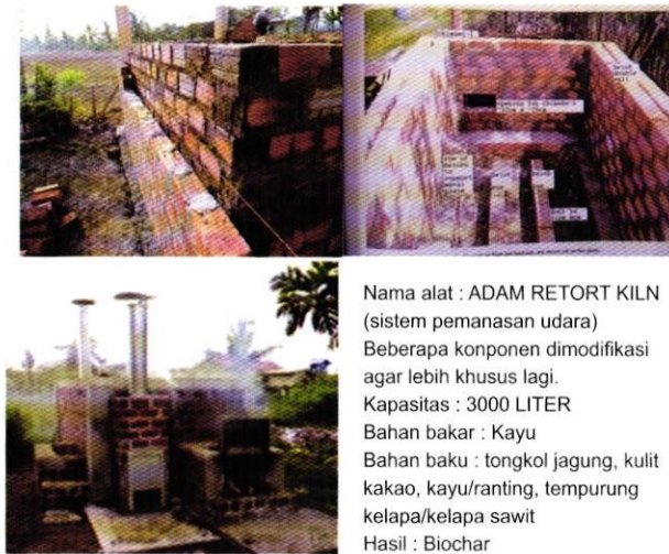
Gambar 14. Pirolisator model Adam Retort Kiln di KP Taman Bogo, Lampung
