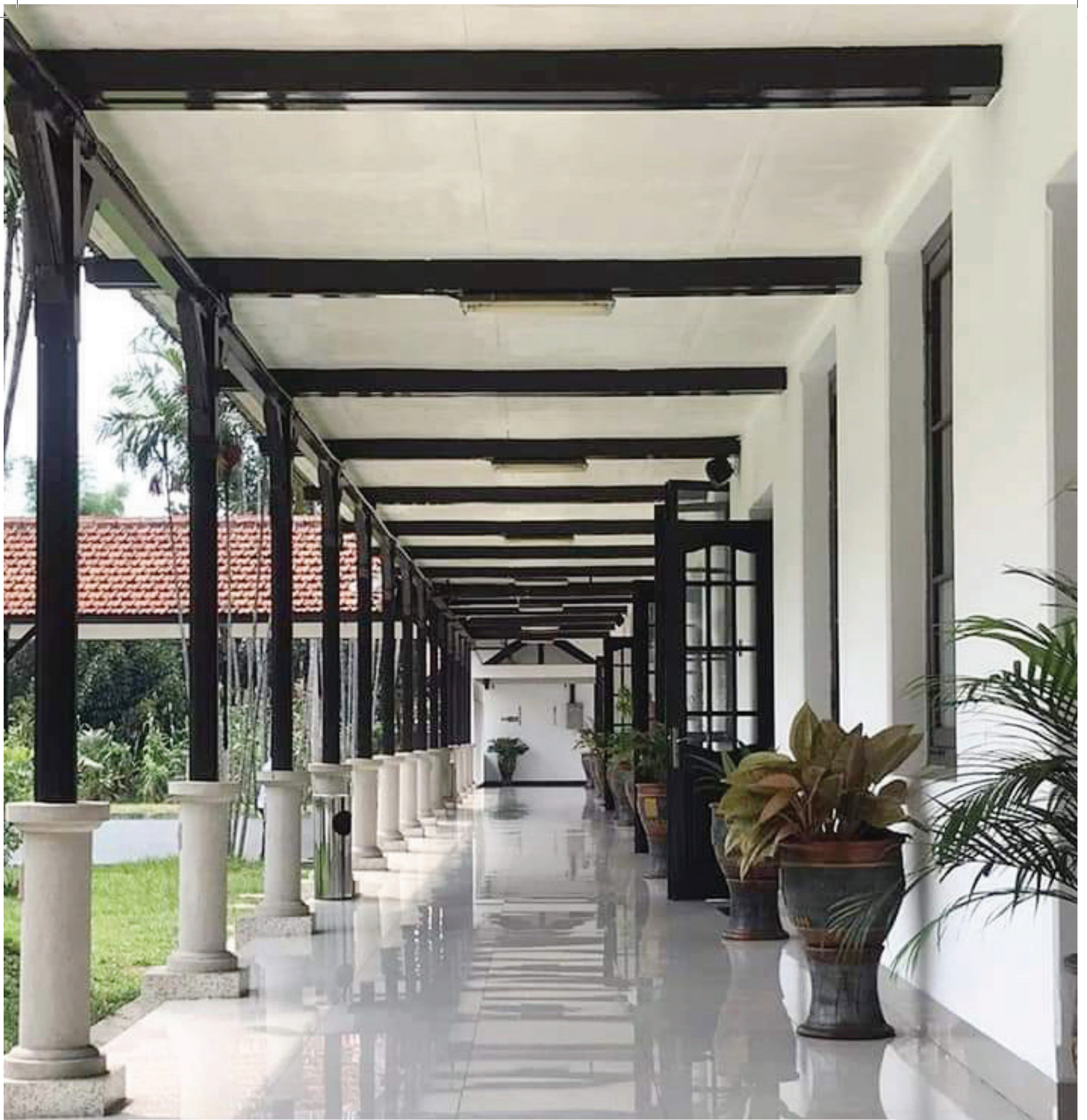
Salah satu selasar di gedung Pusat Penelitian dan Pengembangan Tanaman Pangan yang mencirikan zaman kolonial Belanda. Sumber: Pusat Perpustakaan dan Penyebaran Teknologi Pertanian, Kementerian Pertanian
