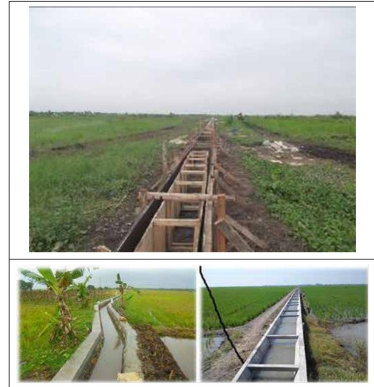
Gambar 26. Instalasi saluran tersier *ferrocement* pada lahan sawah di Pemulutan, Kabupaten Ogan Ilir, Sumatera Selatan, dan contoh rehabilitasi saluran tersier dengan *ferrocement*.
