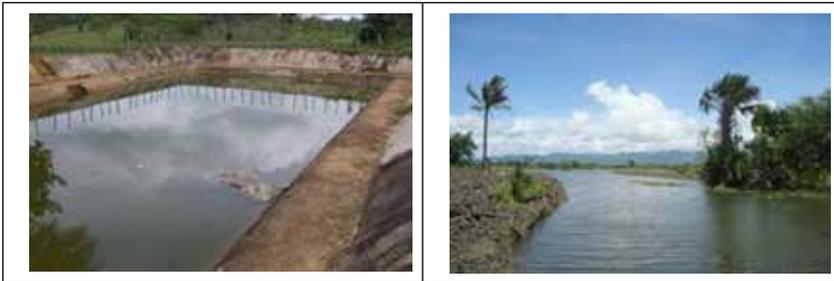
Gambar 11. Embung dengan kontruksi pasangan batu di Gunung Sugih, Lampung Tengah (kiri) dan embung dengan kontruksi lapisan tanah di Naibonat, Kupang, NTT (kanan)
