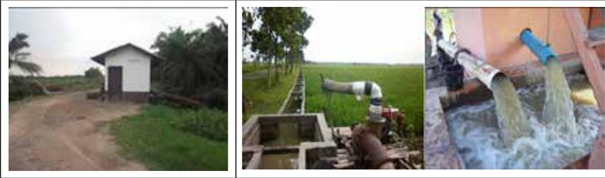
Gambar 17. Pompa aksial di rumah pompa untuk irigasi lahan sawah (kiri), pompa sentrifugal pada lahan sawah (tengah), dan debit air yang dihasilkan (kanan).
