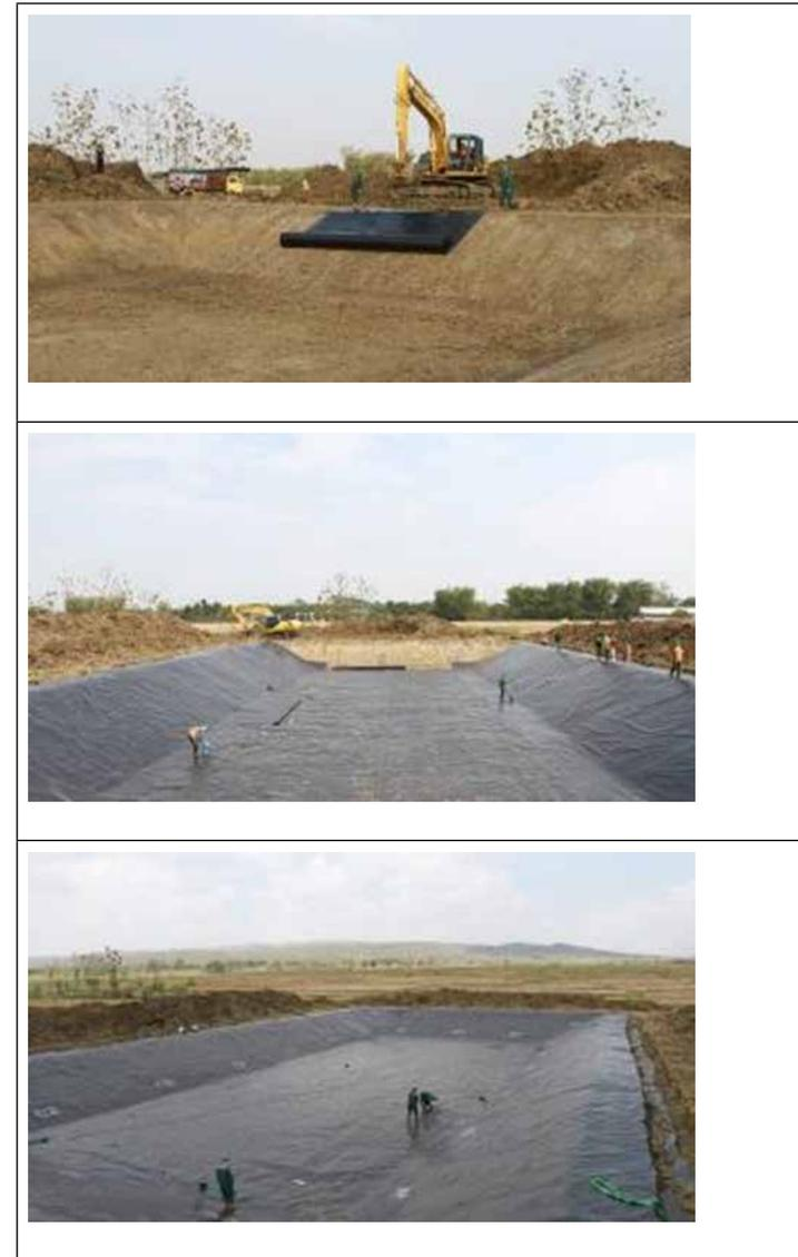
Gambar 21. Pembuatan embung berlapis geomembran di Lamongan, Jawa Timur.
