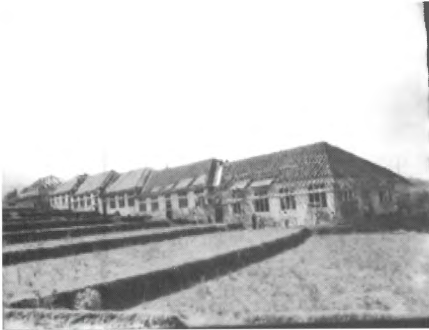
Gedung Mikro AKP
