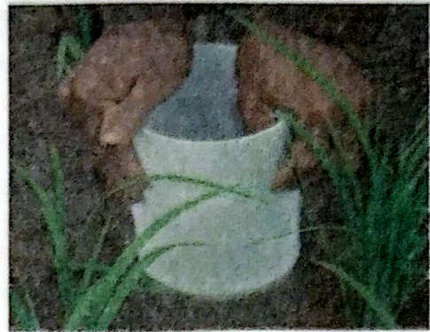
Gambar 12. Cara pemotongan dan pemasangan paralon
