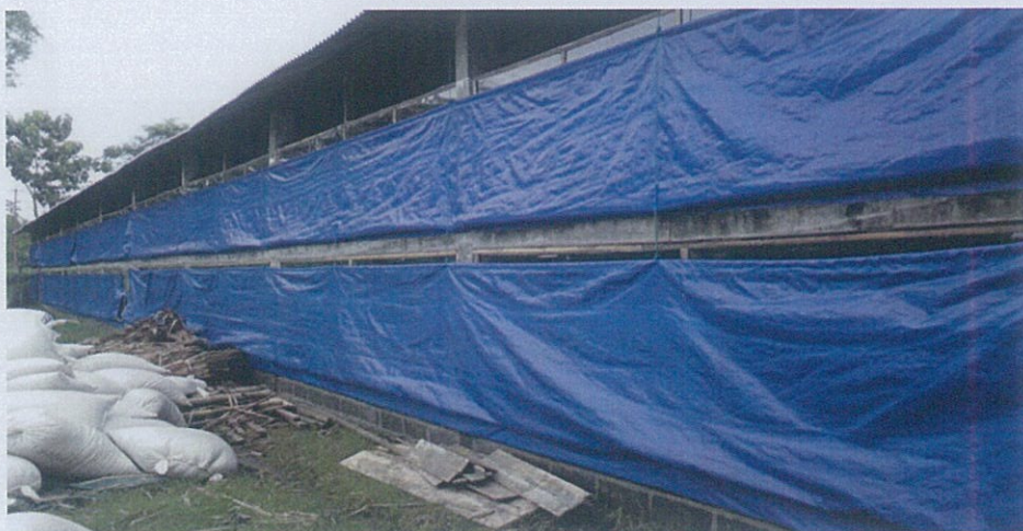
Gambar 13. Cara pemasangan tirai kandang
