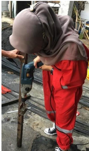
Gambar 4.13. Pengeboran besi L/penghubung
