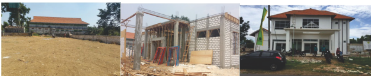
Gambar 86. Perkembangan pembangunan gedung showroom TTP Solokuro
