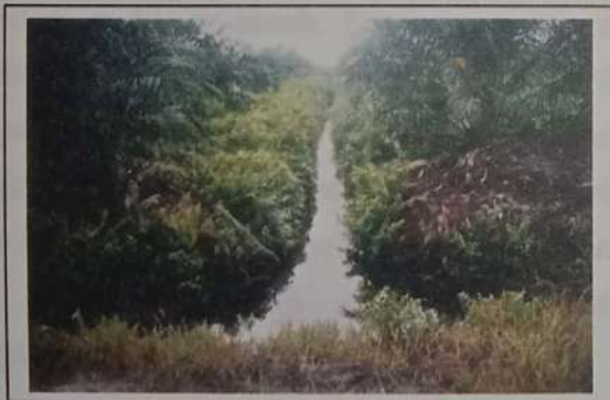
Gambar 2.4 – 2.5. Saluran drainase primer, sekunder dan tersier
