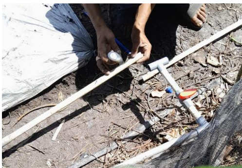
Gambar 8 (a). Pemasangan Pipa
