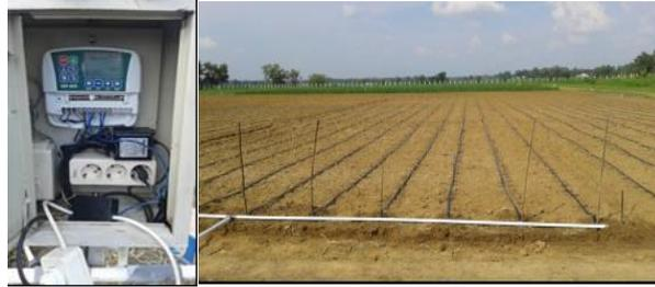
Gambar 6. Kontroler automatik pengatur perlakuan irigasi pada petakan tanaman jagung dan streamline untuk irigasi tetes
