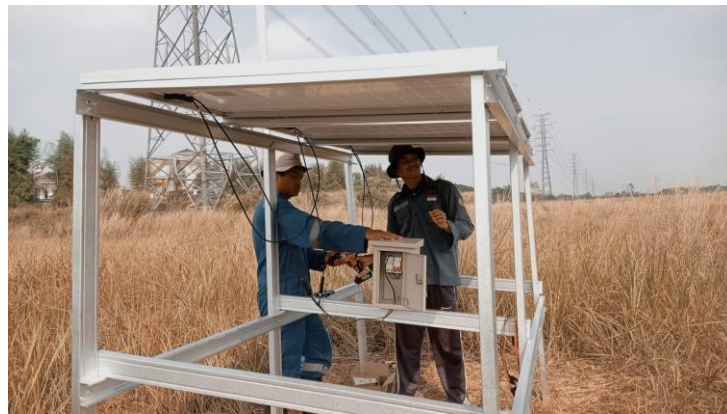
Gambar 4. 24. Pemasangan Box Panel
