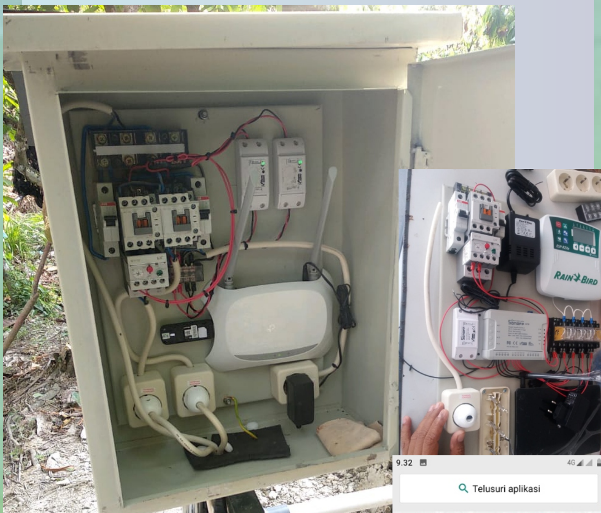
Perangkat otomatisasi irigasi yang dilengkapi kontroler nirkabel
