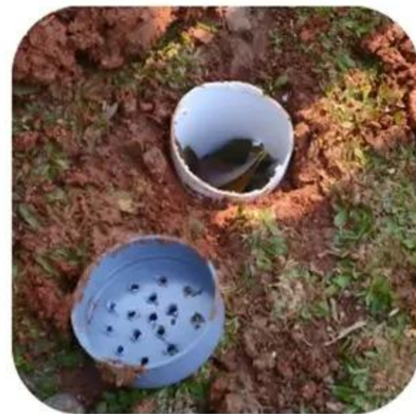
Membuat saluran resapan/sumur biopori
