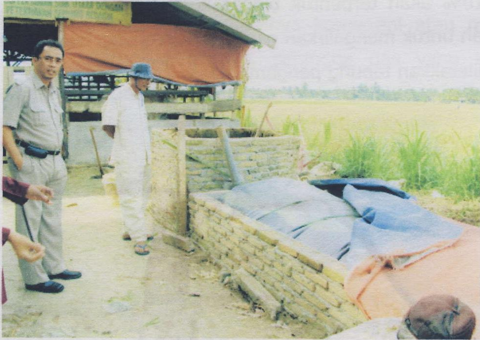
Gambar 4. Reaktor biogas 4000 liter (vol) dengan bak bata
